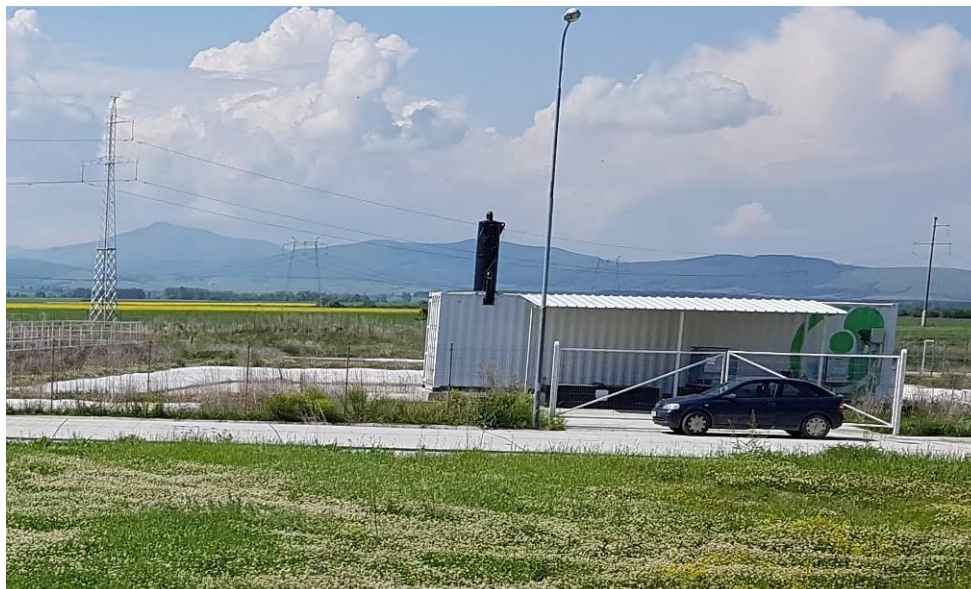
Fig. Nr. 13 - Stație epurare levigat
