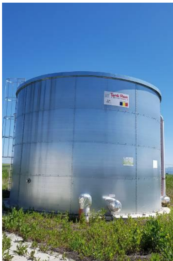
Fig. Nr. 14 - Rezervor cilindric suprateran de 150 mc
